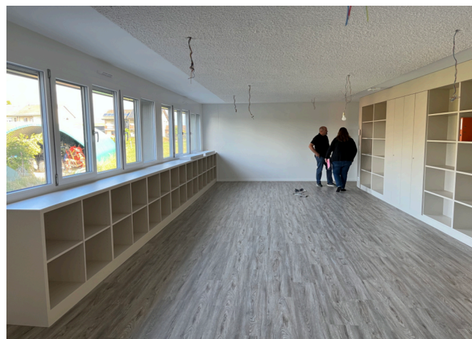
Locaux de l'administration communale en fin de chantier
